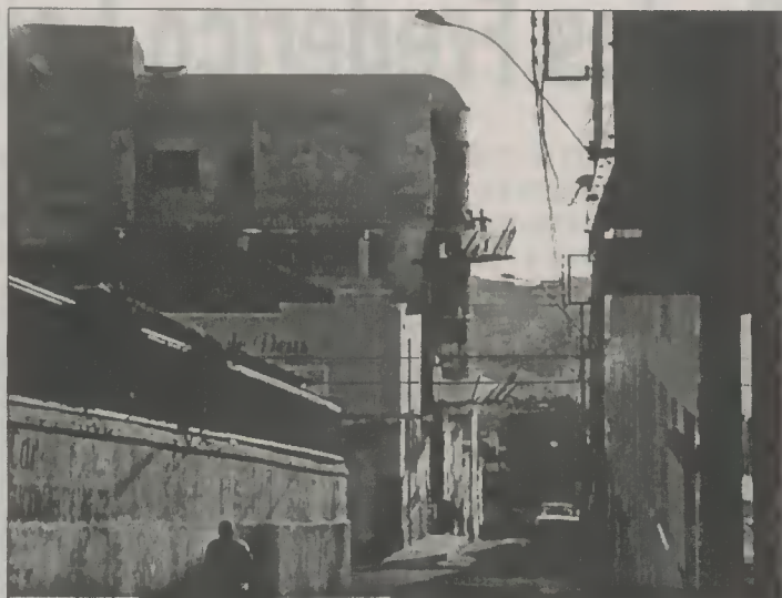
Obra que segundo os engenheiros e arquitetos de Lavras, não está obedecendo a Lei de Uso e Ocupação de Solos
